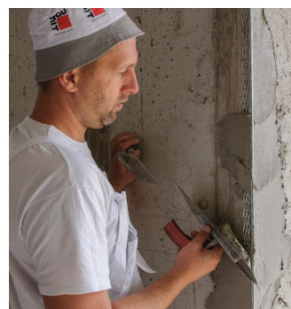
Сл. 14 Измазнување на аголниот профил
