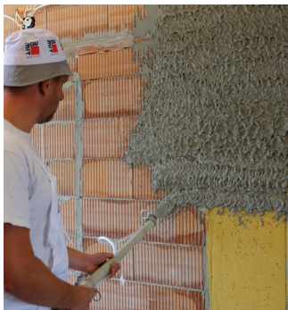
Сл. 17 Нанесување лента со малтер на споевите помеѓу сид од тули и бетонски столбови
