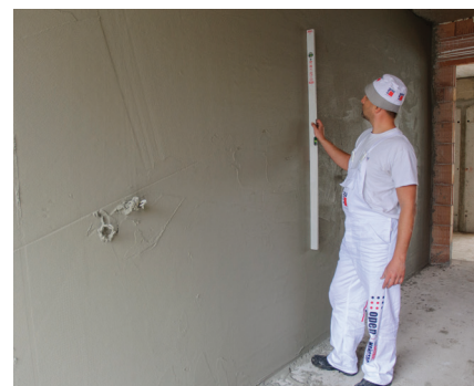
Сл. 21 Контрола на вертикалноста на извлечениот малтер
