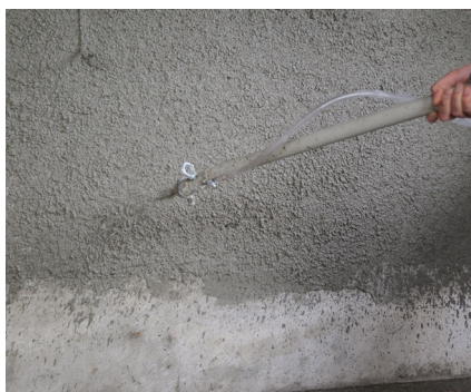
Сл. 7 Прскање со шприц (100% покривност)
