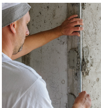
Сл. 12 Монтирање на аголниот профил
