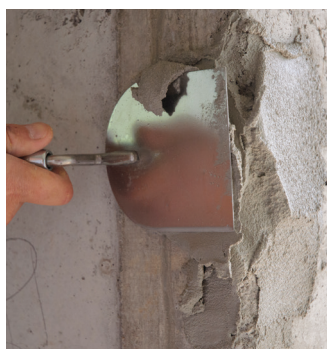
Сл. 11 Примена на смеса за прицврстување на аголен профил
