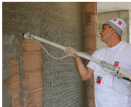
Сл. 15 Нанесување машински малтер на сид од тули
