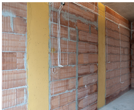
Сл. 10 Нанесен БетонПраимер на бетонски елементи
