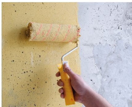
Сл. 9 Нанесување на Баумит БетонПраимер на бетонски сид
